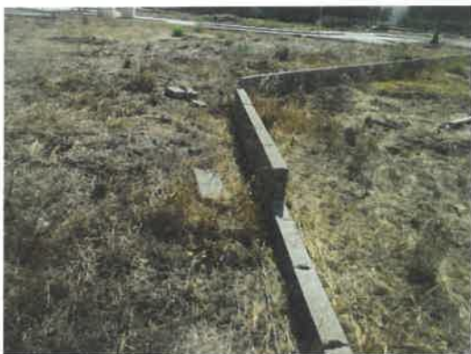
Lote 5 – Murete de delimitação do lote
