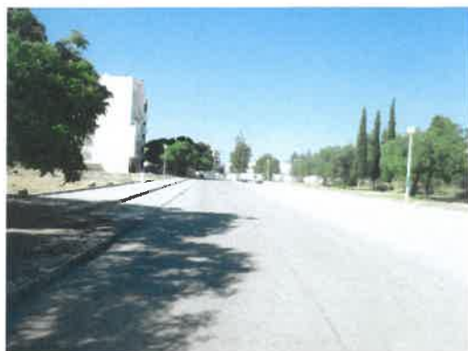
Arruamento de acesso – Rua José Duarte
