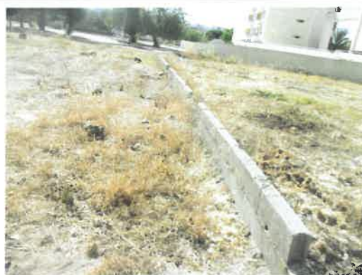
Lote 3 – murete de delimitação do lote
