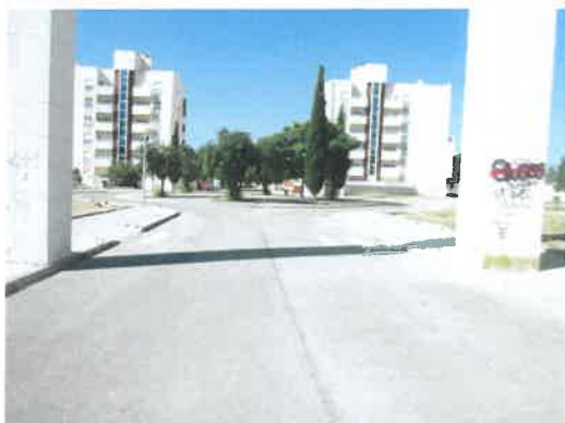
Arruamento central do loteamento
