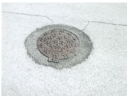
Infraestruturas – rede de esgotos
