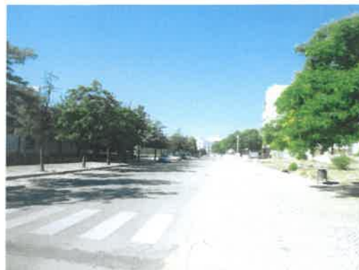
Arruamento de acesso – Rua Délio Nobre dos Santos
