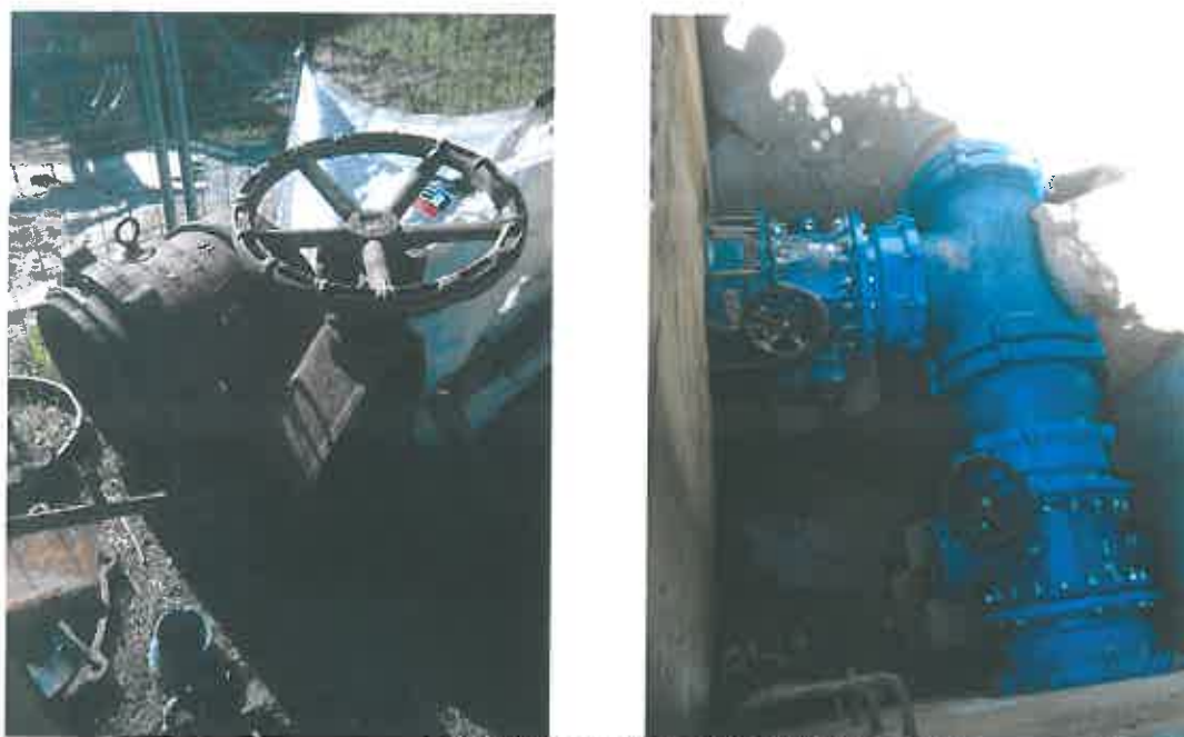
Fig. 3 – Substituição de válvulas de seccionamento DN 500mm na Av. João Meireles
