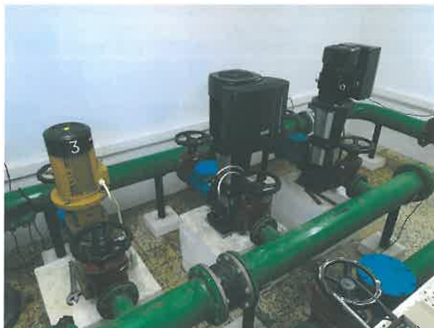
Fig. 2 – Substituição de uma bomba na hidropressora H1
