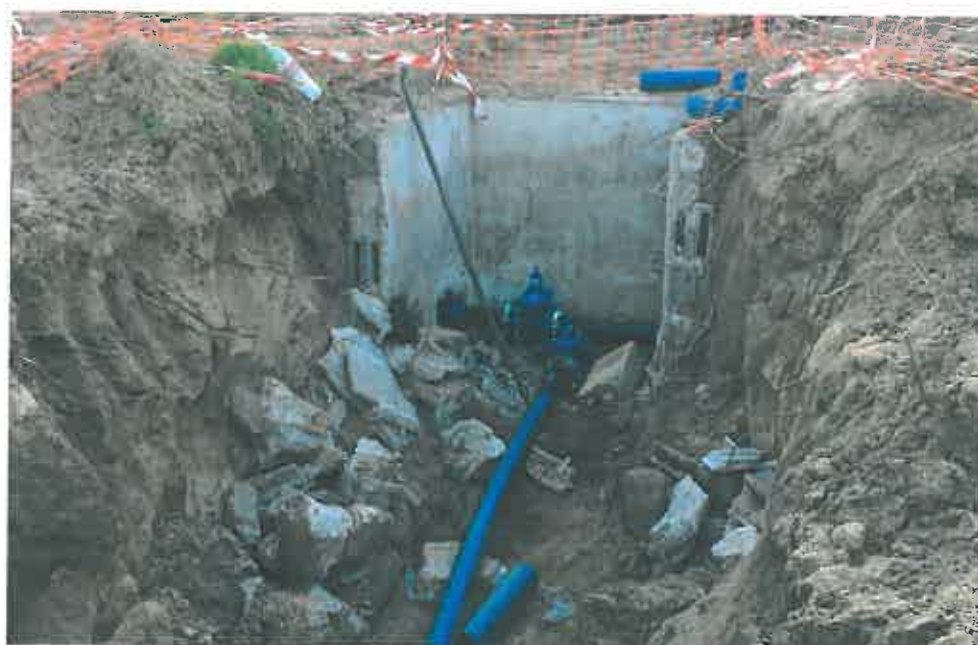
Fig. 4 – Reabilitação de condutas de abastecimento de água da Rua 3, Vila Sol
