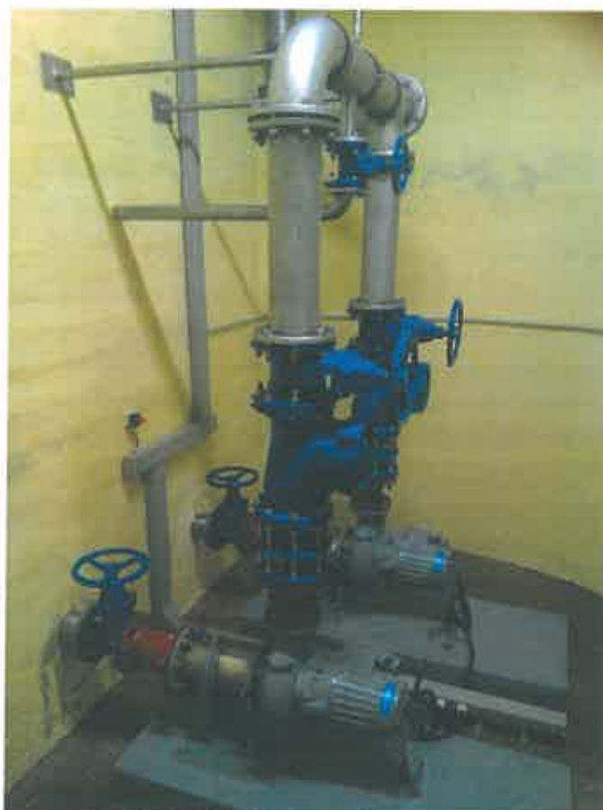
Fig. 5 – Reabilitação da instalação EEAR CCMV
