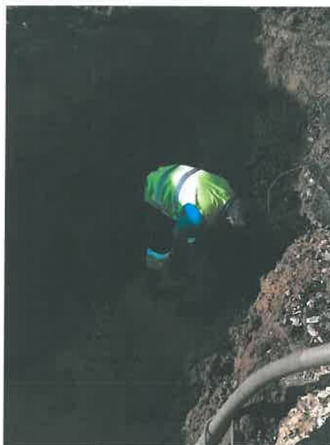
Fig. 1 – Reparação de uma rotura de água ocorrida na Rua do Sol
