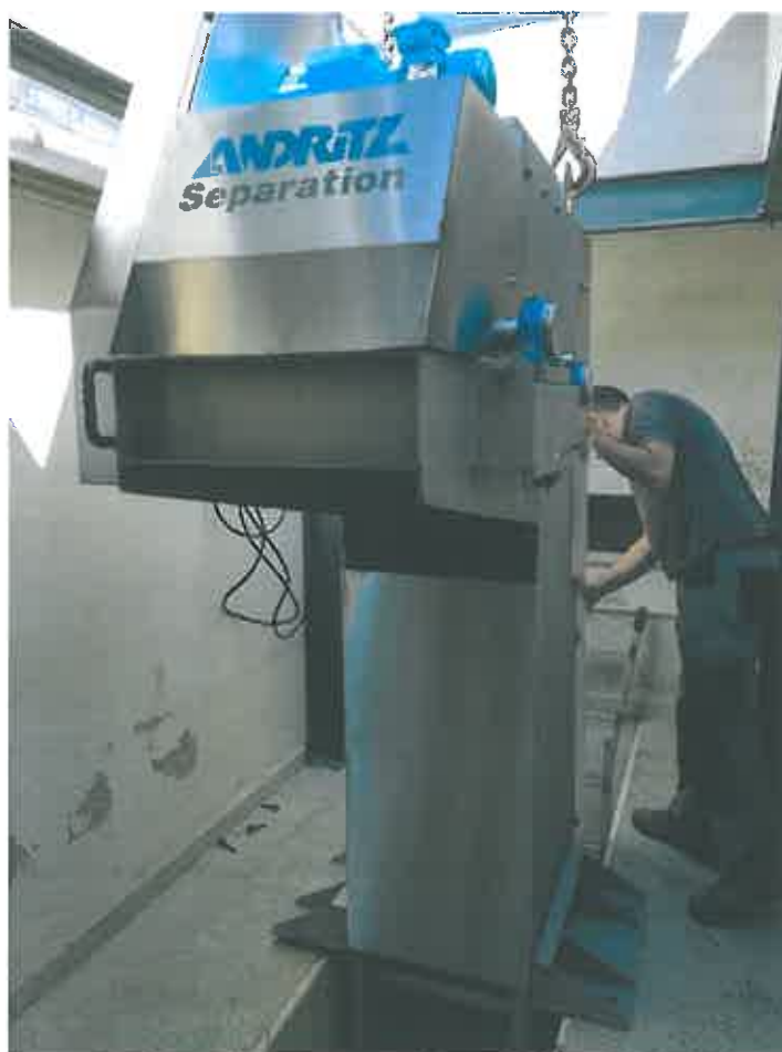
Fig. 6 – Colocação de um tamisador na EEAR da Aldeia do Mar
