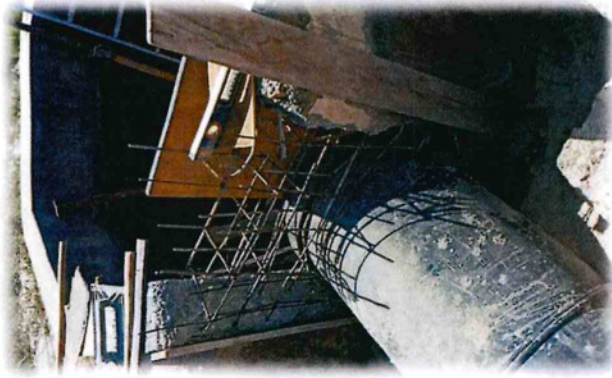
Obras de intervenção
