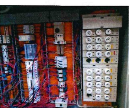
Substituição do quadro elétrico
